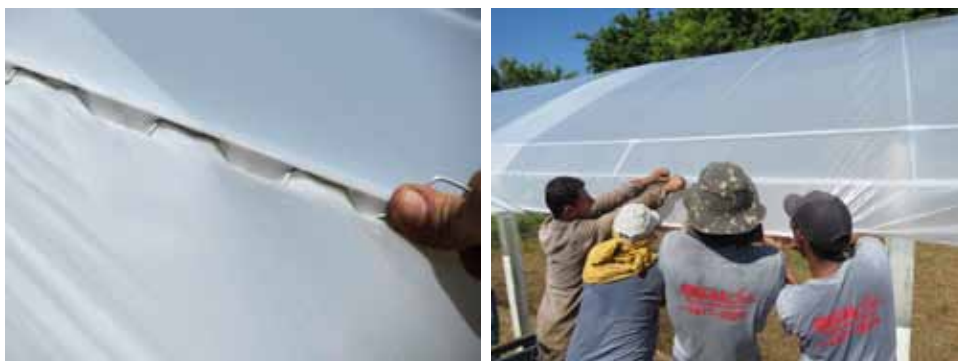
Figura 36. Perfil com mola simples (esquerda) e colocação da mola com o plástico esticado (direita)
