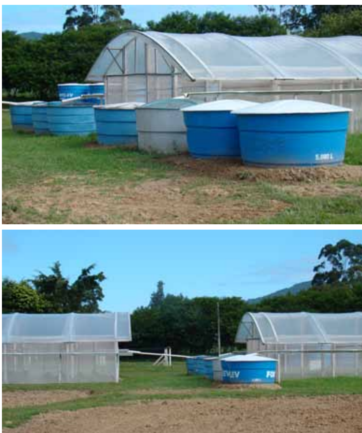
Figura 31. Coleta da água da chuva por meio de calhas laterais instaladas em abrigos de cultivo
