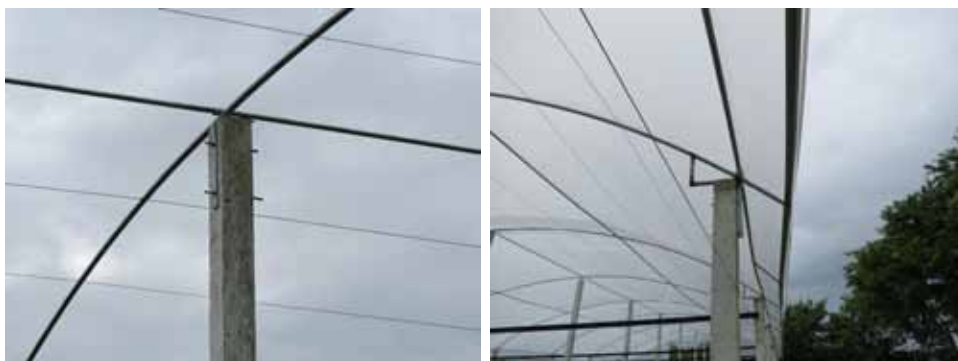
Figura 40. Arames esticados longitudinalmente ao abrigo para redução da vibração do plástico pela ação do vento e para aumento da sua durabilidade
