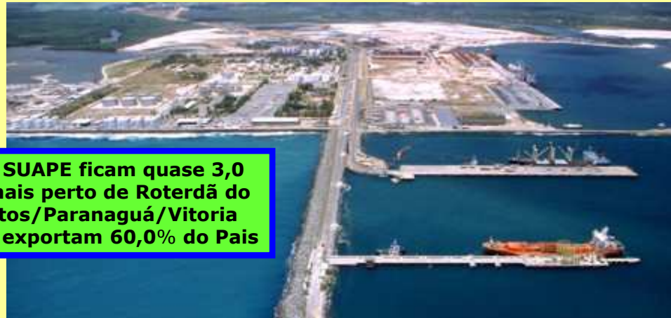
SUAPE (PE) - É o porto que mais cresce no Brasil e já com 100 empresas instaladas (sendo 01 refinaria e 03 estaleiros) e 50 implantando (01 de automóveis e 01 siderúrgica). Em 10 anos deve quintuplicar a carga atual, atingindo 1,0 milhão de contêineres, e chegar a 20 m de profundidade
